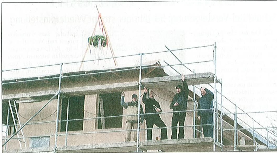
An der Niendorfer Straße entstehen bis 2015 drei Häuser – gestern war Richtfest. Fotos: Ph. Schulze
